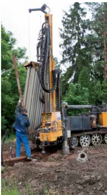
Porakaivo on yleisin maalämpöpumpun lämmönlähde.
