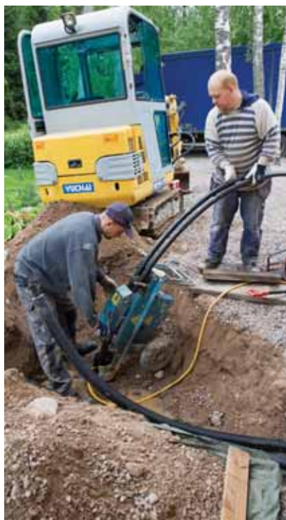
Lämmönkeruuputkisto asennetaan porakaivoon ja täytetään jäätymättömällä keruuliuksella.
